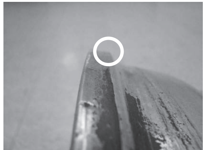
die scharfen Kanten wurden entfernt
